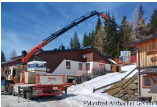
Arbeiten bei winterlichen Bedingungen Mitte Mai 2023
