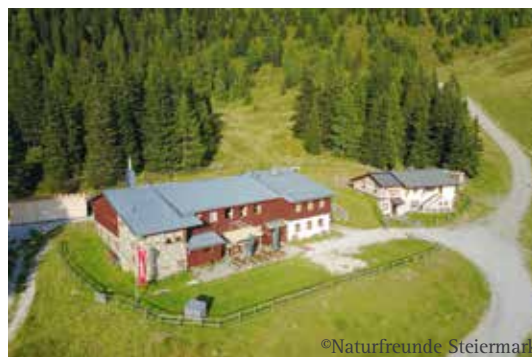
Die Hauser Kaiblingalm vor den Umbaumaßnahmen
